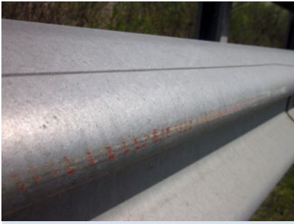
Bild 2: Vollständig wirksamer Korrosionsschutz im Bereich einer Beschädigung
