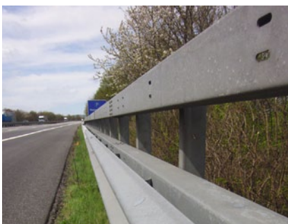
Bild 1: Optische Erscheinung des Rückhaltesystems nach vier Jahren Testphase mit ressourceneffizientem Korrosionsschutzsystem
