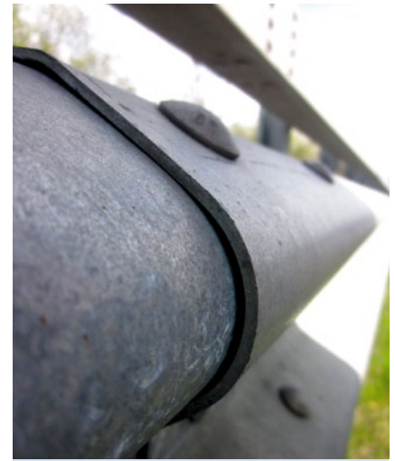
Bild 3: Vollverzinkte Schnittkante
