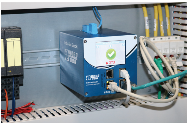
„Stiller Wächter“ im Schaltschrank: Der PROFIBUS-INspektor NT zeigt bereits auf dem Display den aktuellen Netzwerkgesamtzustand an und liefert erste Diagnosehinweise.
