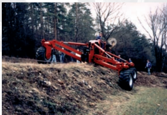
Einpflegen an einer Böschung.
