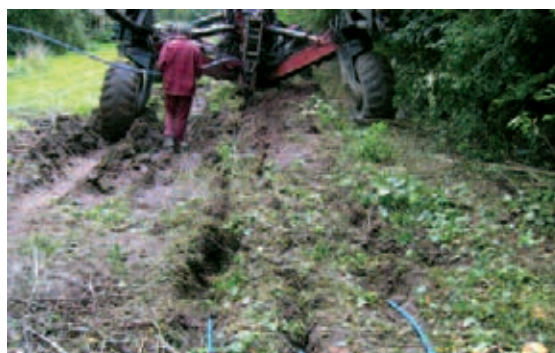
Einpflegen von Kollektorleitungen PE-HD DA 32 mit 50 cm Abstand.
