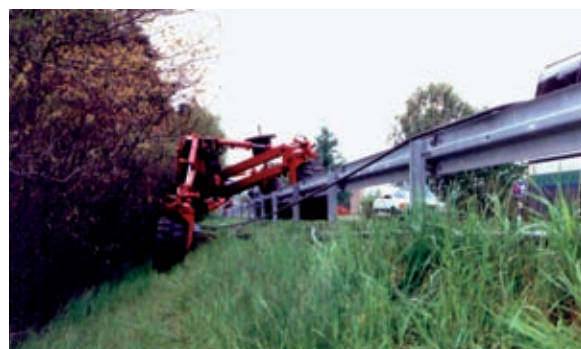
An einer Leitplanke.
