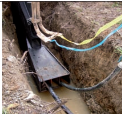
Verlegeschacht für parallele Verlegung der Leitungen nebeneinander.
