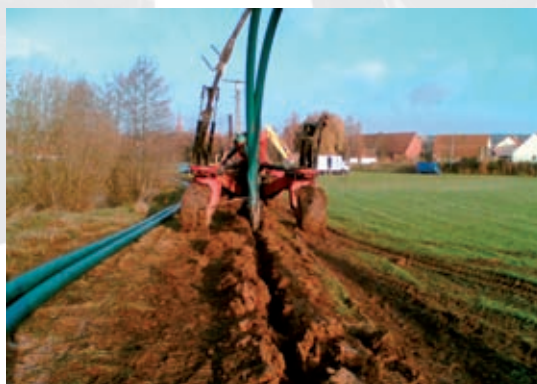
Einpflegen zweier Abwasserdruckleitungen PE-HD DA 225.
