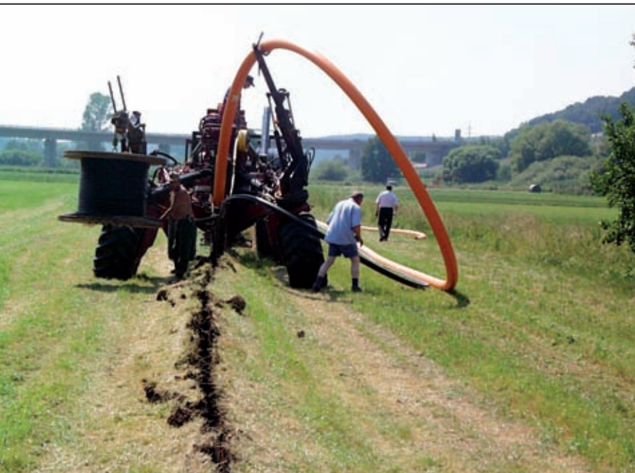
Einpflegen einer Gasleitung PE-HD DA 180, Steuerkabel und Dreifachschutzrohr 3 x 50.
