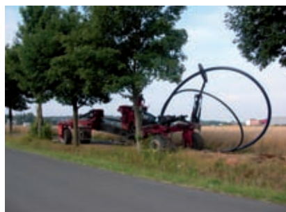
Einpflegen einer Trinkwasserleitung DA 160 und Abwasserdruckleitung DA 90.
