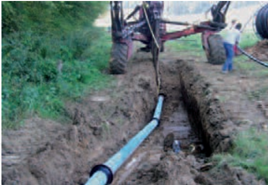
Startgrube und Raketenpflug beim Einziehen einer Gussleitung DN 150.
