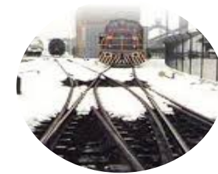
Weichenheizung Bahnhof Farchant, Zugspitze
