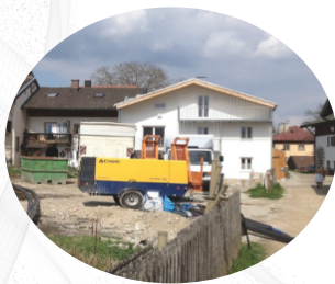
EFH Frauenchiemsee, Trinkwasserschutzgebiet
