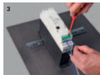
3 Steuerstrom verdrahten.
